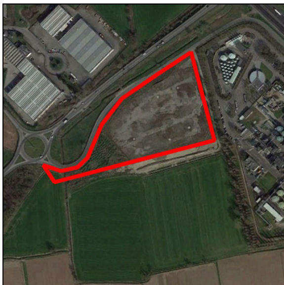
Figura 9. ATP-PL 1. Foto aerea
