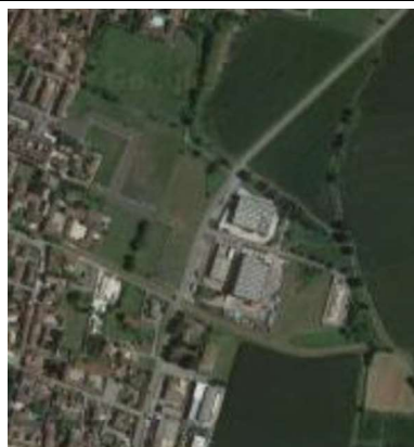
Vista da Foto aerea
