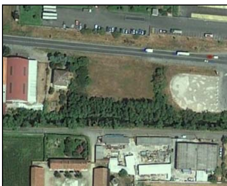
Figura 3. ATC-PL 2. Foto aerea
