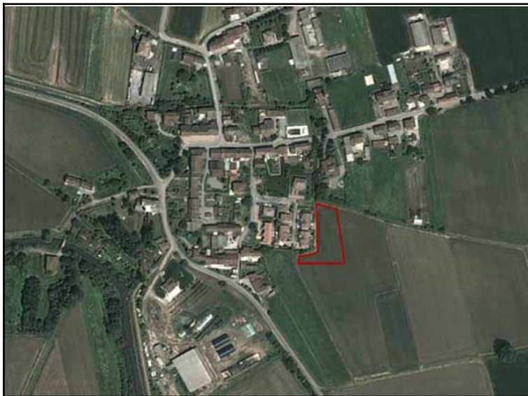
Figura 3. ATR-PCC 6. Foto aerea
