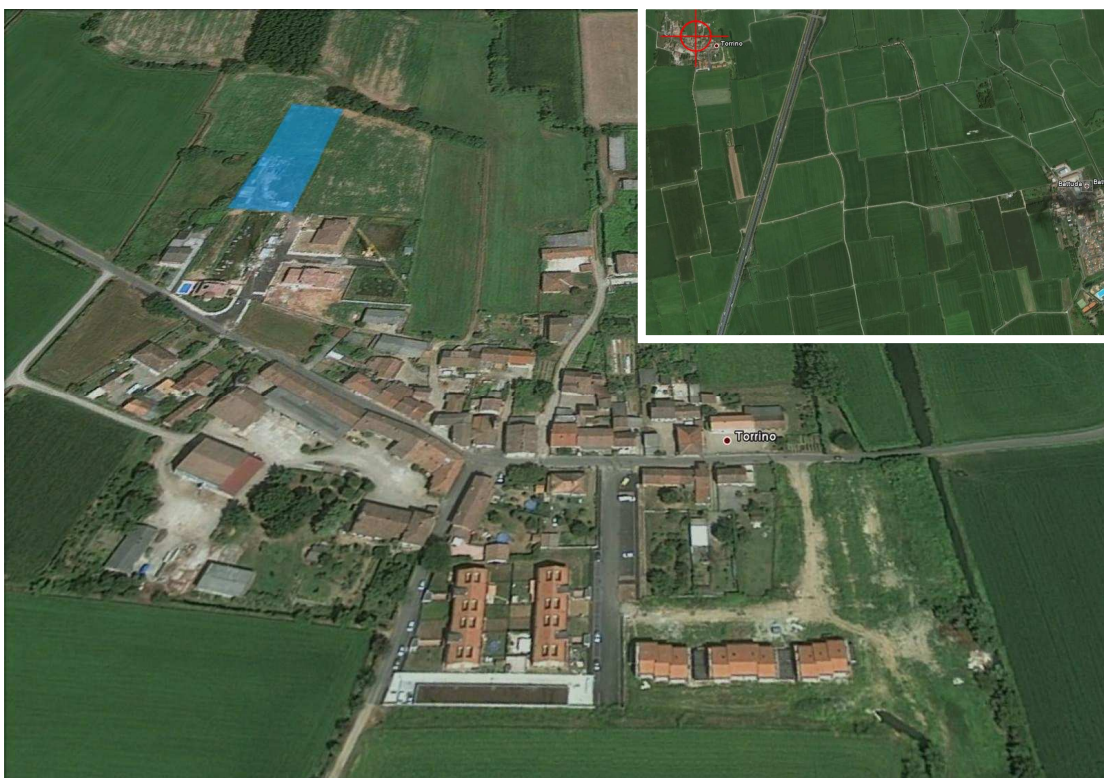
Figura 9 - At 3 - Ortofoto dell'area oggetto di trasformazione
