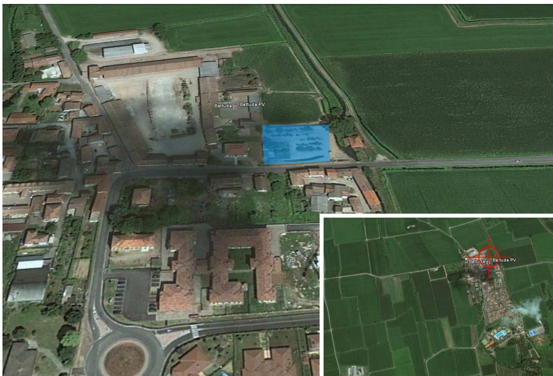
Figura 1 - At 1 - Ortofoto dell'area oggetto di trasformazione
