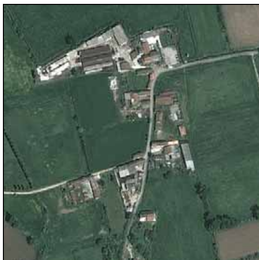
Figura 3. ATR-PCC 3. Foto aerea
