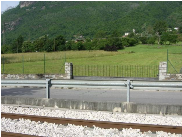
Vista verso ovest
