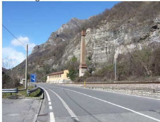
vista da via de gasperi
