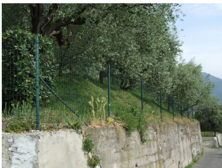
vista da via strada a valle dell'Adt
