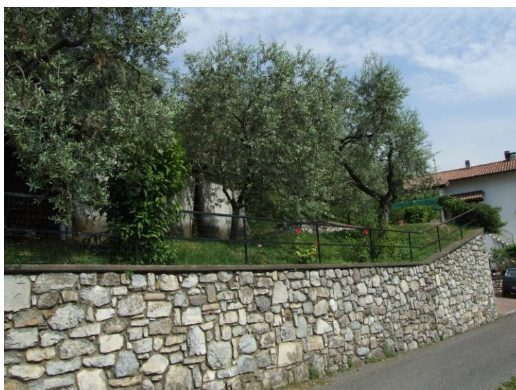
vista da via strada a valle dell'Adt
